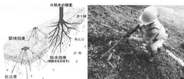
写真-1 鉄根打設工法概念図と施工状況 3)
