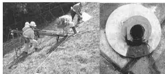
写真-2 鋼製有孔パイプによる盛土対策例 4)
