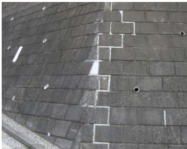
写真-2 経過を観察すると判断された擁壁の事例
