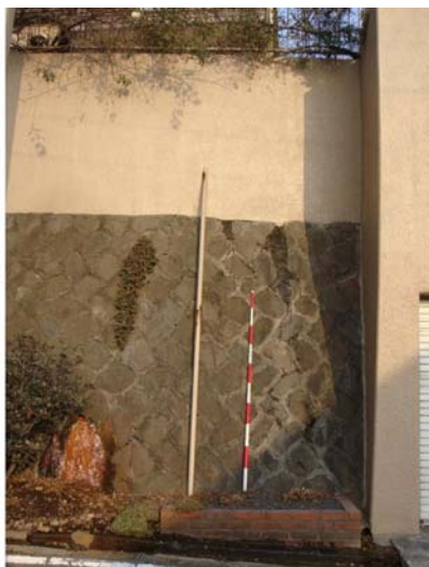
写真-1 対策が必要と判断される擁壁の事例
