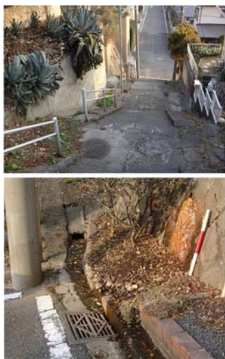
写真-1 対策が必要と判断される擁壁の事例
