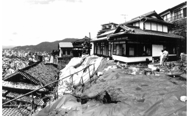
写真-1 崩壊後の現場の様子
