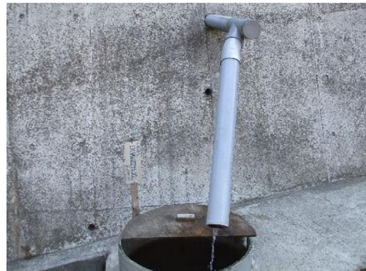
図-4 図-3の崩壊対策後は湧水を災害時の井戸として利用
