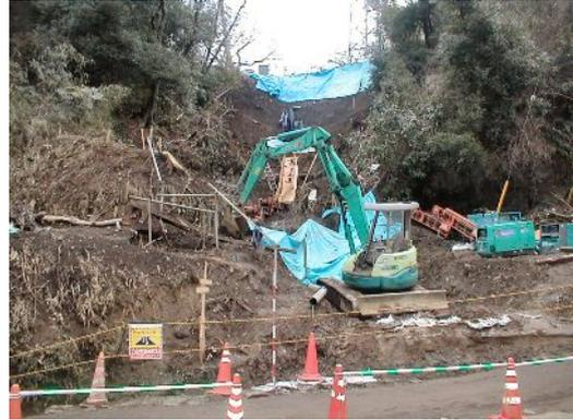
図-3 公園斜面の崩壊とその対策中
