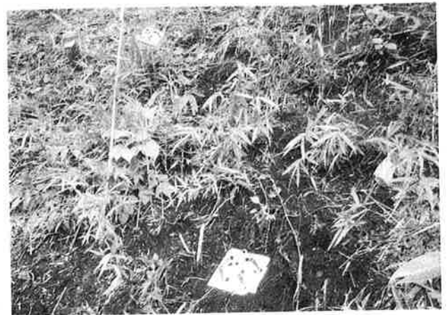
写真-6 鉄根打設工法の施工後の状況
