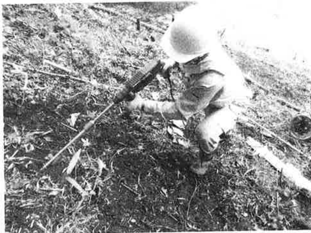
写真-4 鉄根打設工法の施工状況
