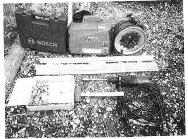
写真-5 鉄根打設工法の施工状況
