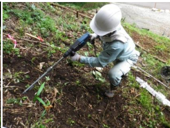
鉄根の打設状況
